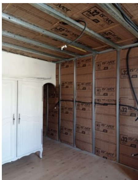
Isolation des murs et du plafond
