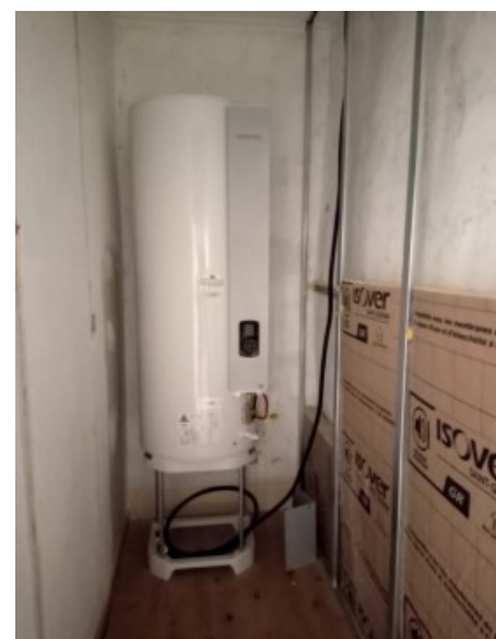
chauffe-eau thermodynamique
